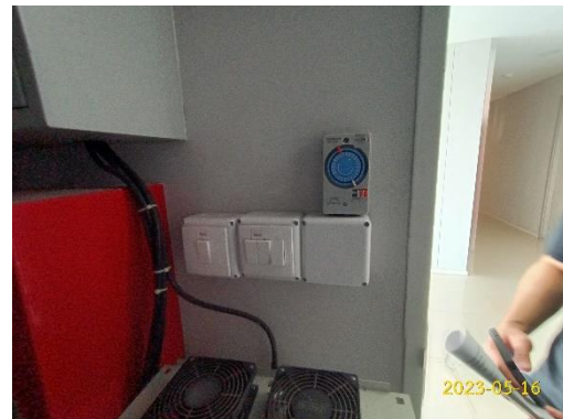
ระบบเปิด-ปิดไฟ ด้วยการตั้งเวลา
