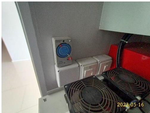
ระบบเปิด-ปิดไฟ ด้วยการตั้งเวลา
