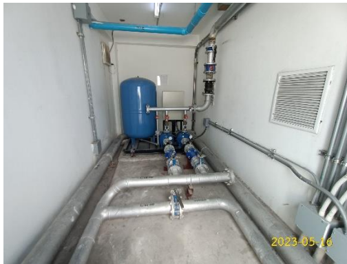
ปั้มน้ำ/ปั้มเสริมแรงดันอาคาร A
