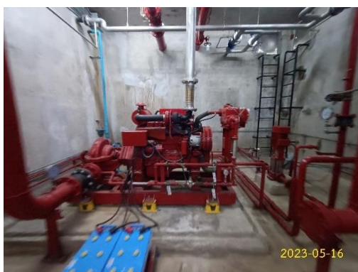
เครื่องสูบน้ำแบบเครื่องยนต์/เครื่องสูบน้ำดับเพลิงช่วย
